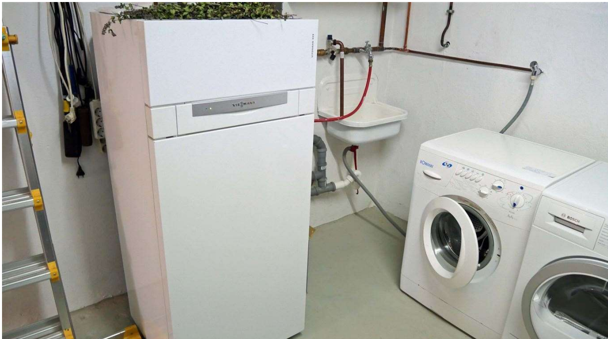
Gas-Brennwert-Zentralheizung Baujahr 2005
